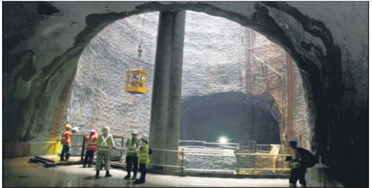
公用局将探讨是否可将地下储水库做为储存雨水的长期方案。（雷普权提供照片）
